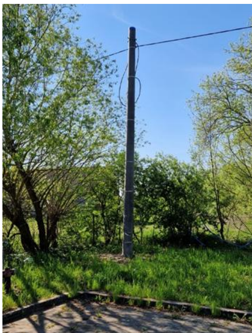
Przebudowa infrastruktury elektroenergetycznej
