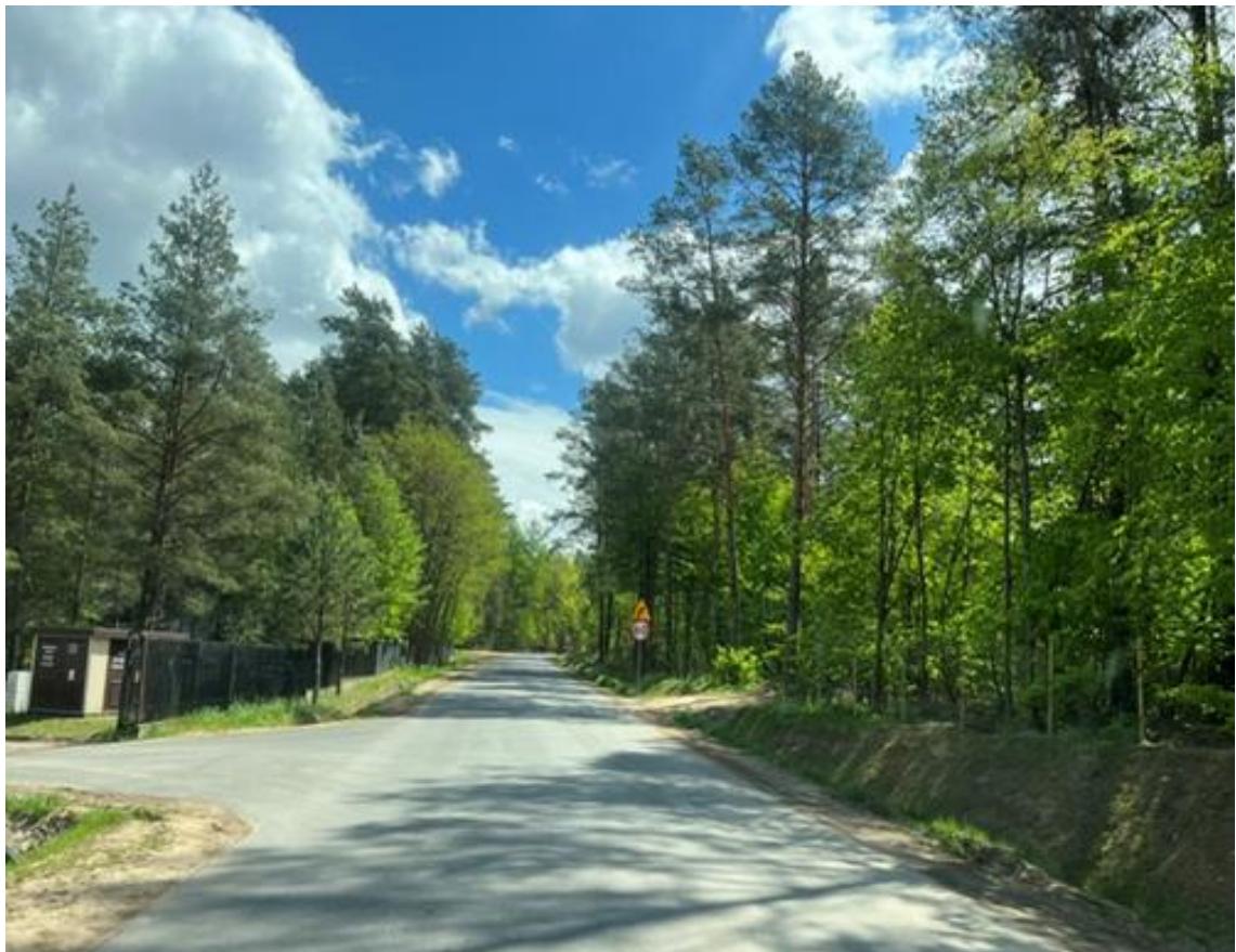
Modernizacja drogi gminnej nr 107451B na odcinku: Ploski – droga krajowa nr 19
