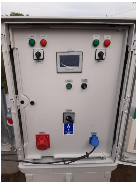
Przebudowa przepompowni ścieków (we wsi Augustowo i Parcewo)
