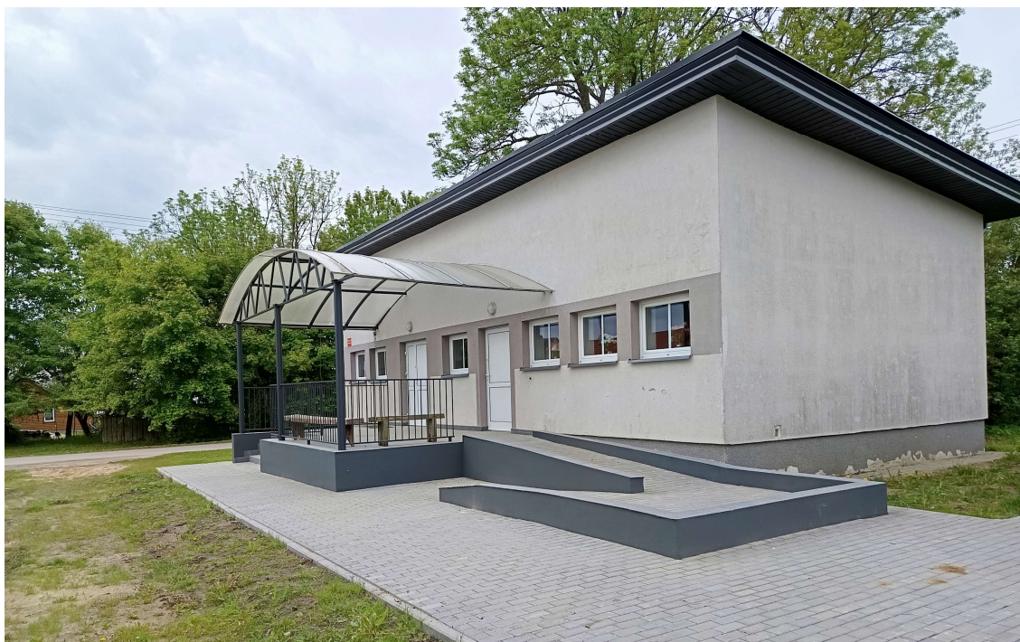
Fot.6 Wykonana w 2024r. modernizacja świetlicy we wsi Truski. – wyk. UG Bielsk Podlaski
