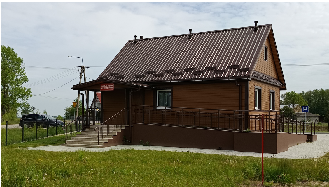
Fot.5 Wykonana w 2024r. modernizacja świetlicy we wsi Stołowacz – wyk.UG Bielsk Podlaski
