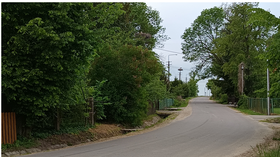
Fot.13 Wykonana w 2024r. nowa nawierzchnia ulicy we wsi Zawady – wyk. UG Bielsk Podlaski
