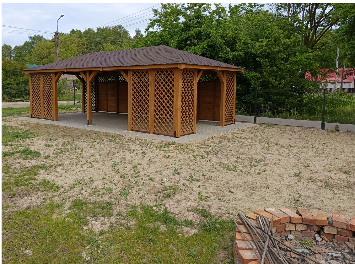
Fot.12 Wybudowana w 2024r. altana we wsi Sobótka – wyk. UG Bielsk Podlaski
