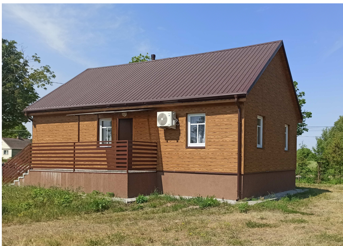
Fot.18 Wykonana w 2023r. termomodernizacja świetlicy wiejskiej we wsi Hryniewicze Duże – wyk. UG Bielsk Podlaski
