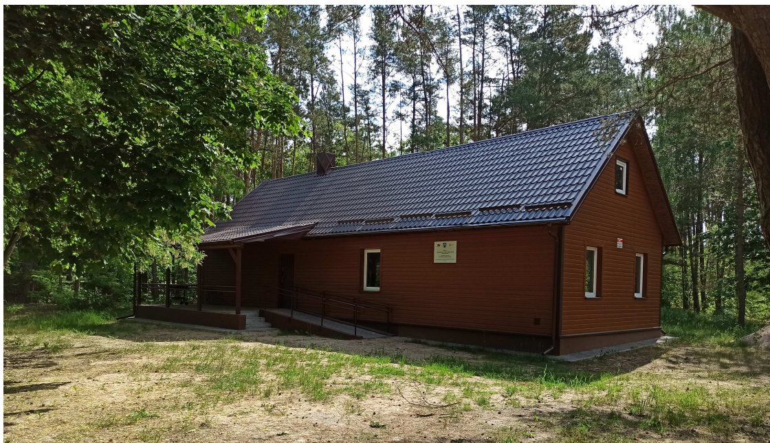
Fot.3 Świetlica wiejska we wsi Deniski 2023r. – wyk. UG Bielsk Podlaski
