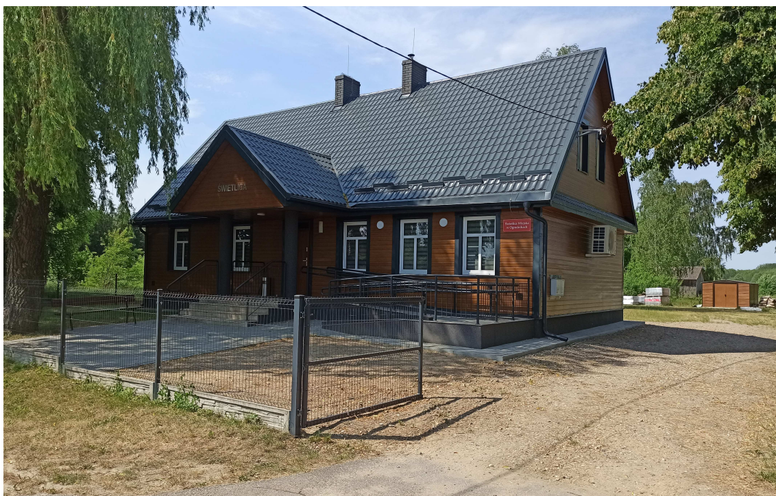
Fot.7 Przebudowana w 2023r. świetlica wiejska we wsi Ogrodniki – wyk.UG Bielsk Podlaski
