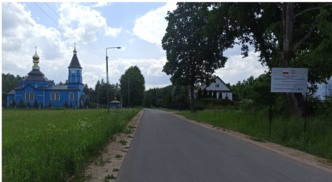
Fot.17 Przebudowany w 2023r. odcinek drogi gminnej Podbiele – granica gminy (z Gminą Orla) – wyk. UG Bielsk Podlaski
