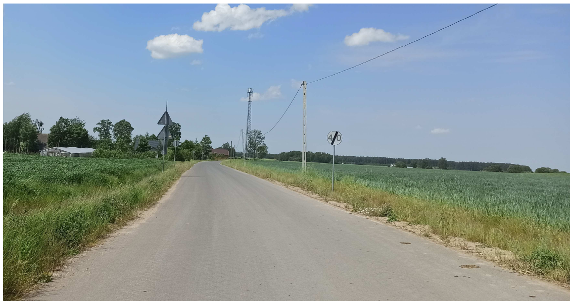
Fot.13 Przebudowana w 2023r. droga gminna nr 107468B odcinek Knorydy - Knorydy Gaj – wyk. UG Bielsk Podlaski
