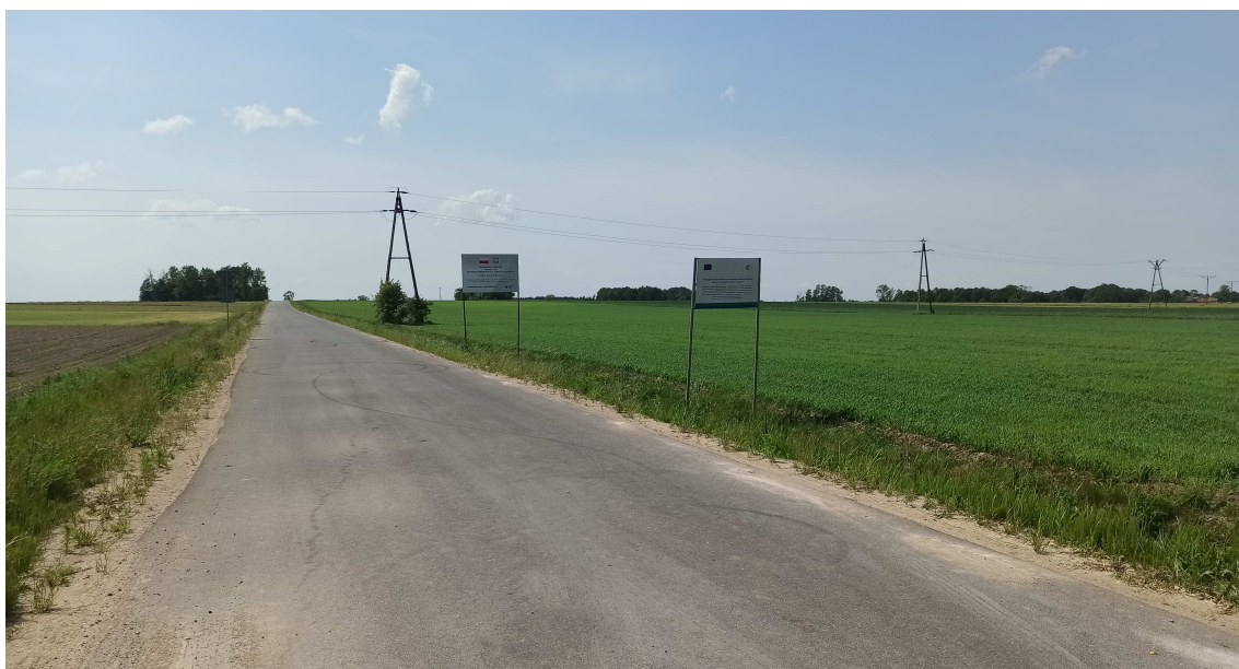
Fot.16 Przebudowany w 2023r. odcinek drogi gminnej Bolesty – Kol.Bolesty – wyk. UG Bielsk Podlaski
