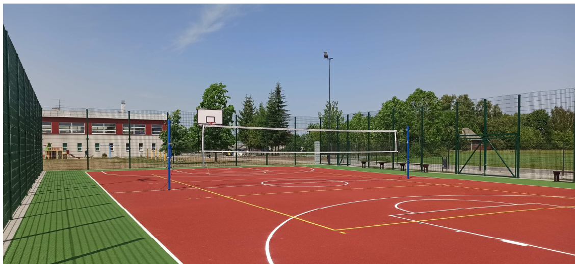
Fot.14 Wybudowane w 2023r. boisko sportowe przy Szkole Podstawowej im. Jana Pawła II w Łubinie Kościelnym – wyk. UG Bielsk Podlaski
