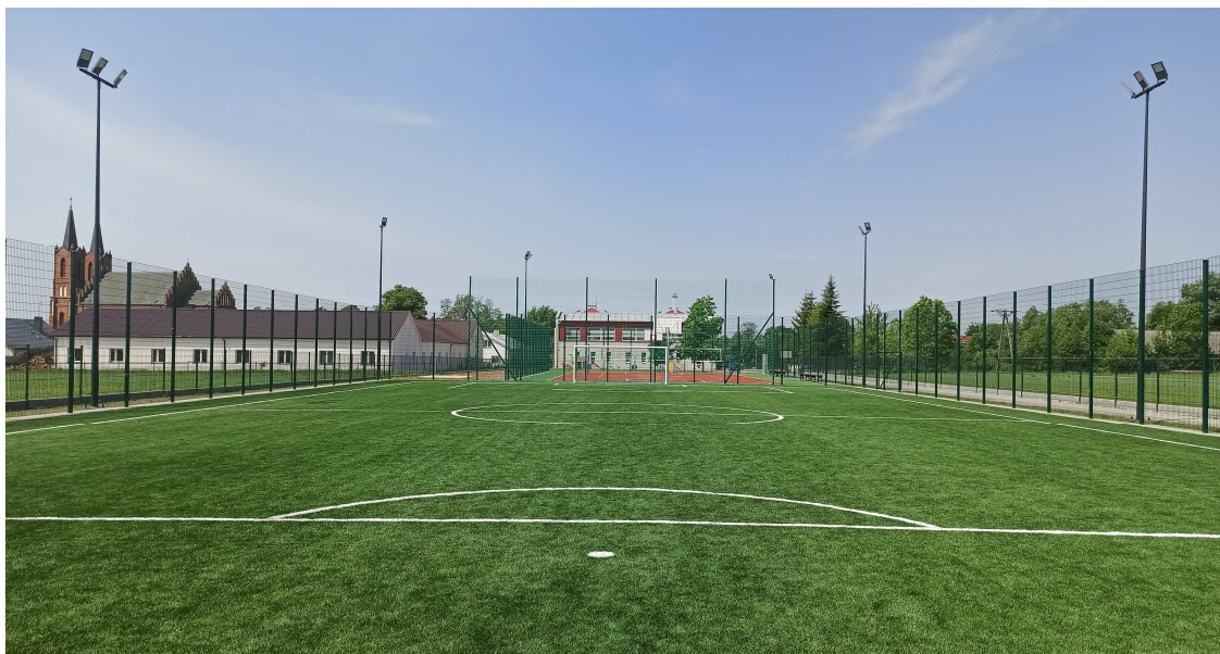
Fot.15 Wybudowane w 2023r. boisko sportowe przy Szkole Podstawowej im. Jana Pawła II w Łubinie Kościelnym – wyk. UG Bielsk Podlaski
